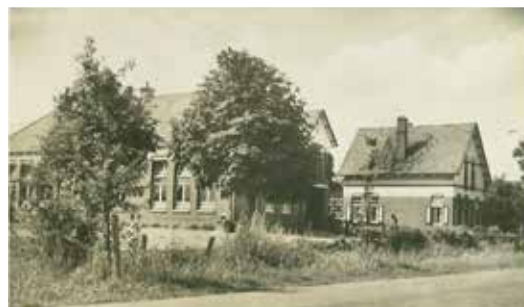
De voormalige school
