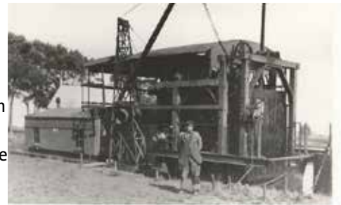
De Baggelmachine maakte het werk voor de veenarbeiders vele malen lichter...
