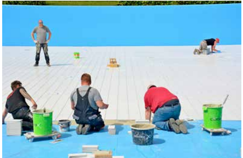
In de brandende zon wordt keihard gewerkt om de zwembadvloer waterdicht te maken. (Foto: Bart Ledegang)
